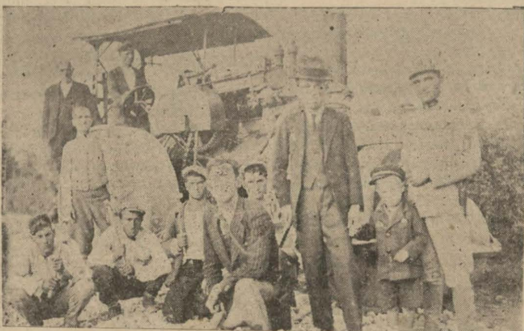
Akyazıda yol çalışması
